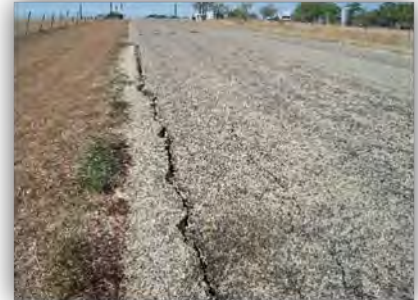
Longitudinal Cracking
